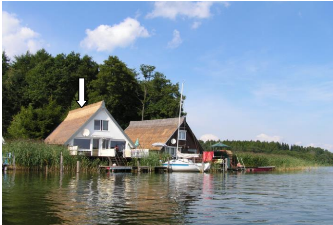
Linkes Haus, mit den großen Panoramafenstern!
